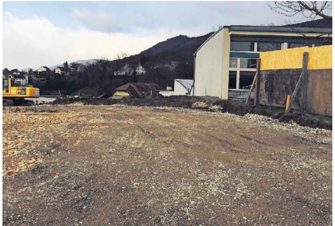
Baupiste beim Schulhaus Spärli: Zum Schutz der Schulkinder wurden Holzabschrankungen montiert.
